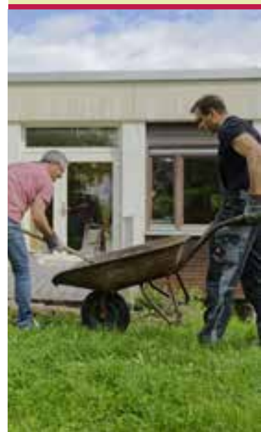
Unten: Patrick Cox und Hausmeister Schwencke setzen das Ende der Kindergarten-Brücke instand.
